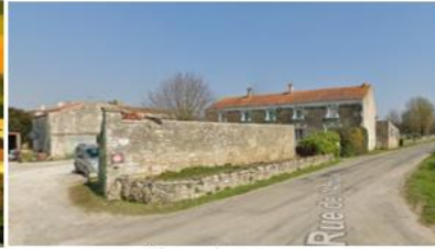
Les constructions côté sud (hébergement)
